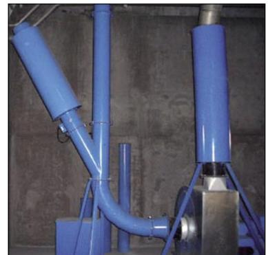
Abb. 6: Zerreiventilator mit Gehuseschalldmmung
