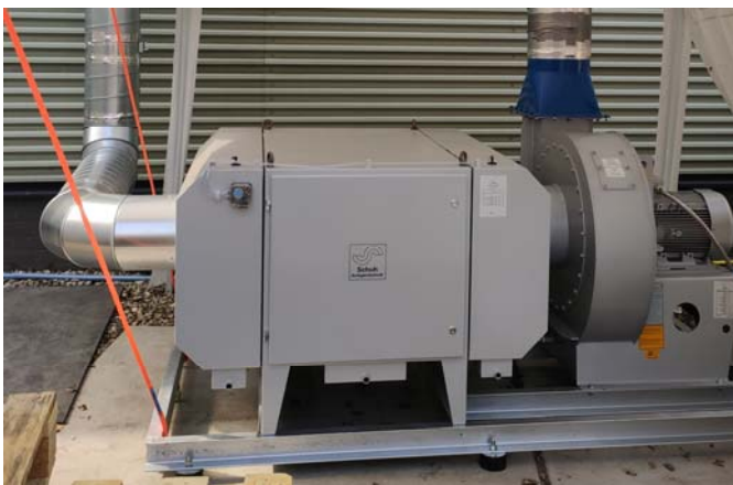
Abb. 1: Dunstabscneider KC mit Radialventilator auf Rahmen
