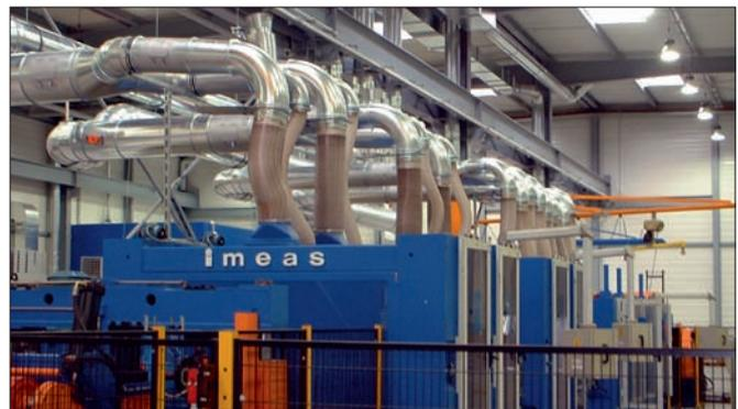
Abb. 6: Blick auf die Absaugeinrichtungen an den Bearbeitungsmaschinen
