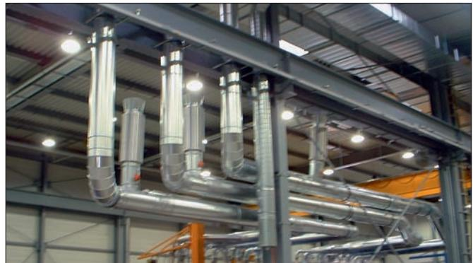
Abb. 3b: Verrohrung des Entstaubungssystems
