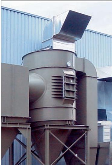
Abb. 4a: Funkenabscheider und Jetfilter
